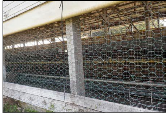
畜舎のネット整備
