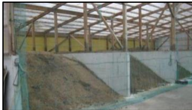
堆肥舎のネット設置
