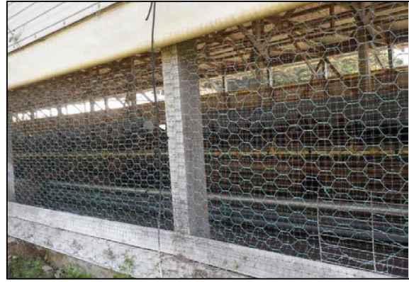
畜舎のネット整備
