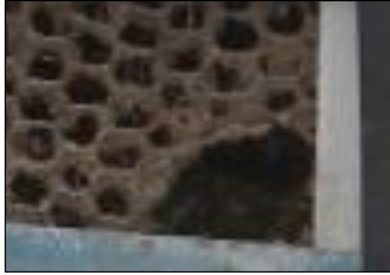
畜舎の破損部の修繕
