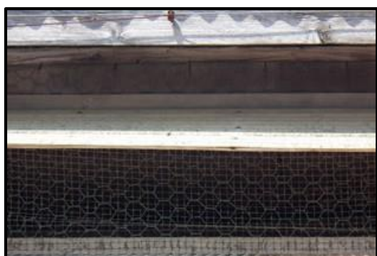
換気口のネット設置
