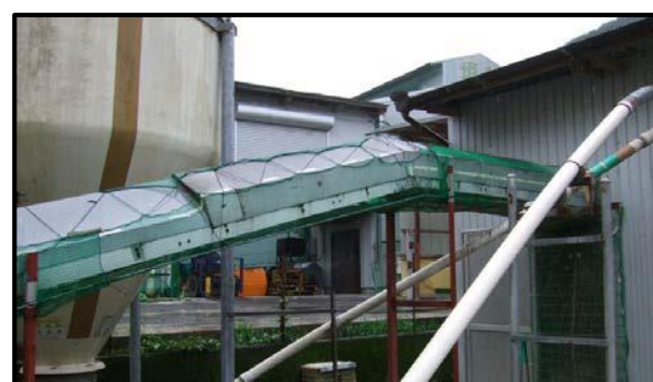
鶏糞搬出口のネット設置
