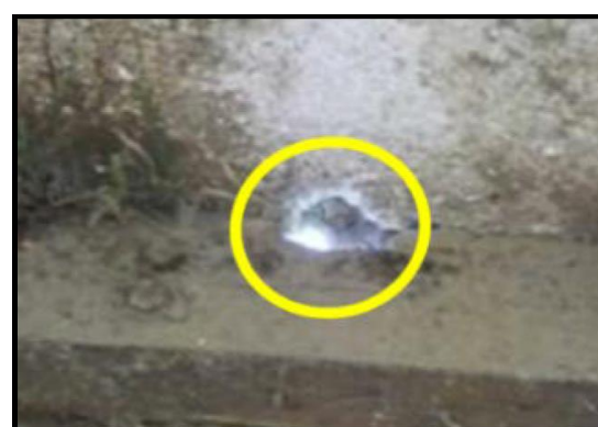
壁等の破損修繕
