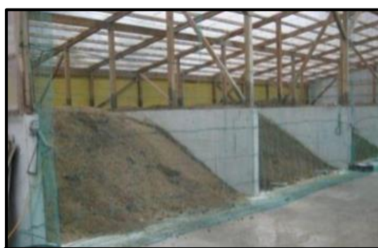
堆肥舎のネット設置
