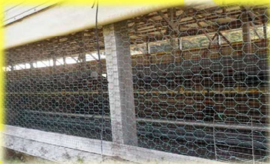
防鳥ネット設置
