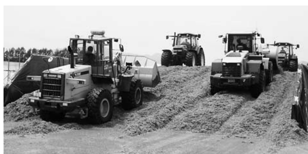
写真2 踏圧車両4台による踏圧風景
