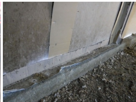
⑧壁の破損の補修箇所
