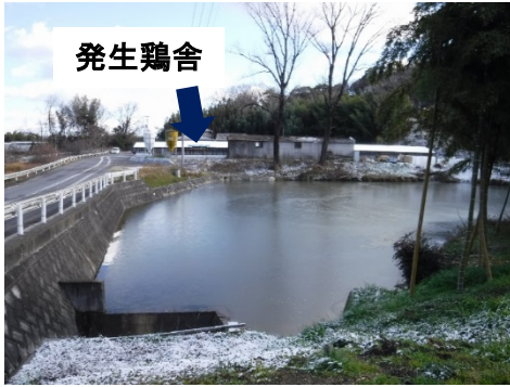
①発生鶏舎に隣接するため池
