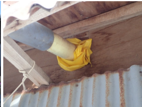
⑥配管を通す穴の隙間の補修
